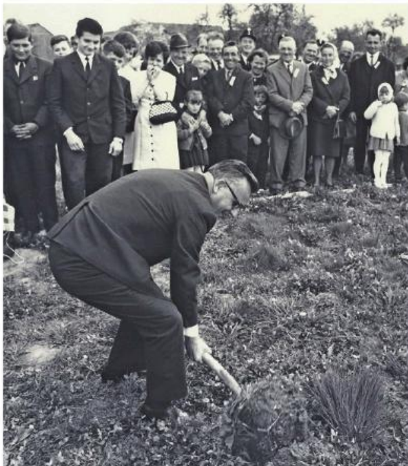
Abb. 4: Der Spatenstich; Quelle: Vienna-Press-Bilder, Wien
